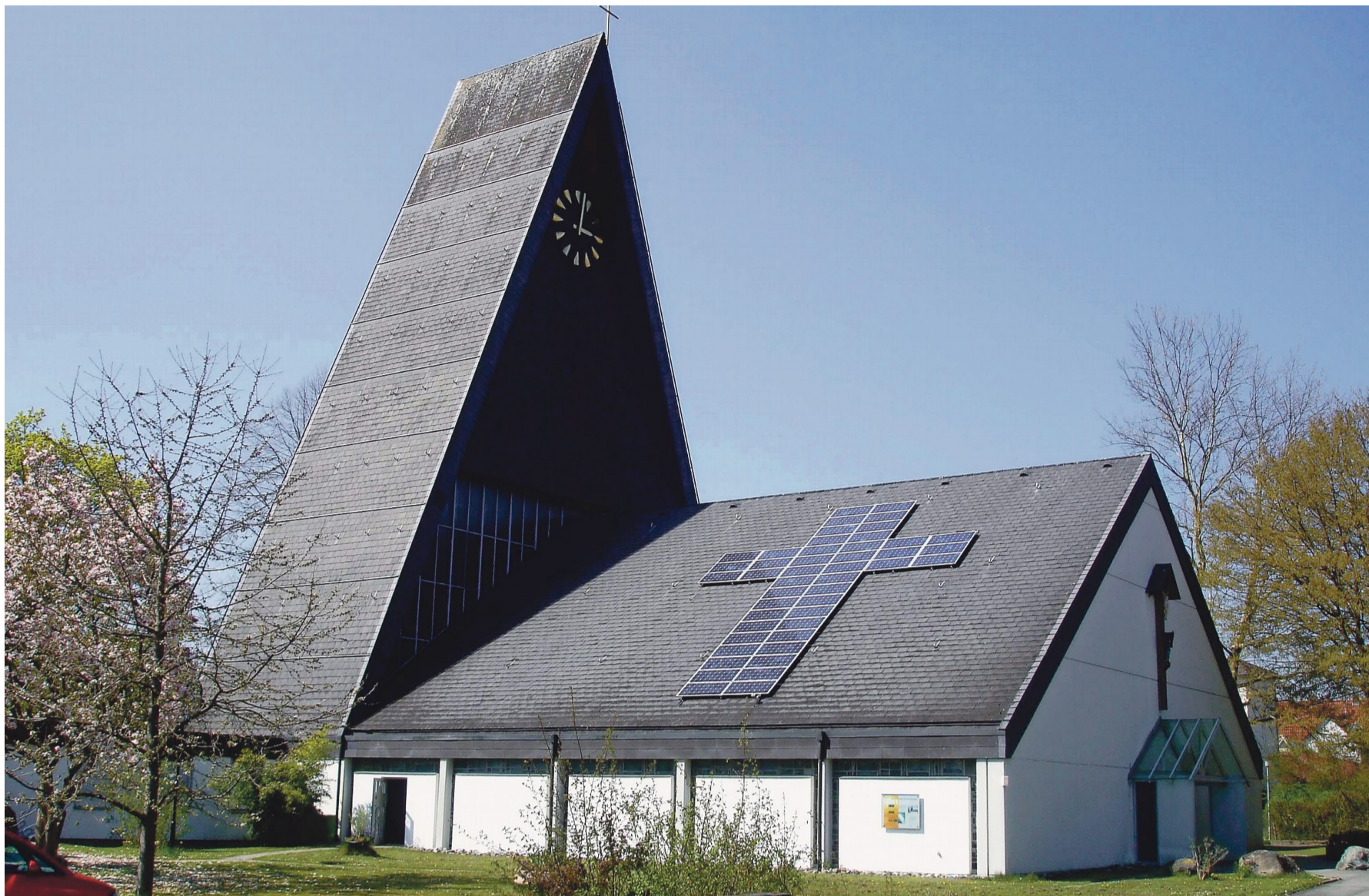
In Deutschland ist das häufiger anzutreffen: Fotovoltaikanlage auf dem Dach der katholischen Kirche St. Peter und Paul in Salem-Neufrach unweit des Bodensees. Foto: zvg
