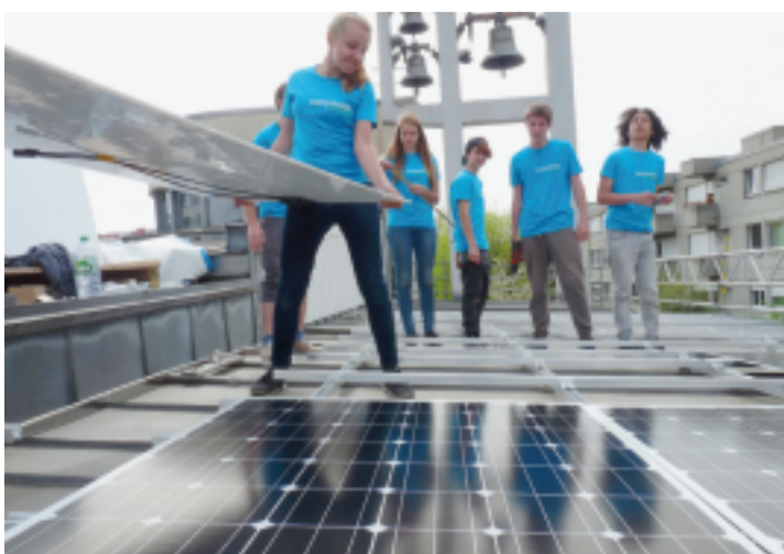
120 Solarpanels montieren die Jugendlichen auf das Kirchendach. cst
