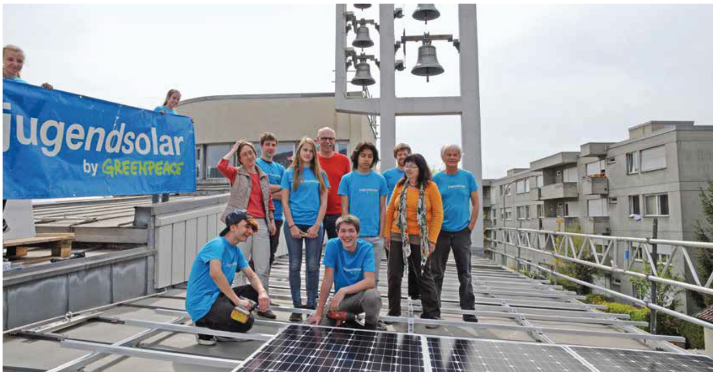
Geschafft: Jugendliche der Projektwoche und Mitglieder der Gruppe «Solarprojekt Bruder Klaus» mit den ersten installierten Solarpanels auf dem Dach der Kirche Bruder Klaus. Foto: Michael Bühler
