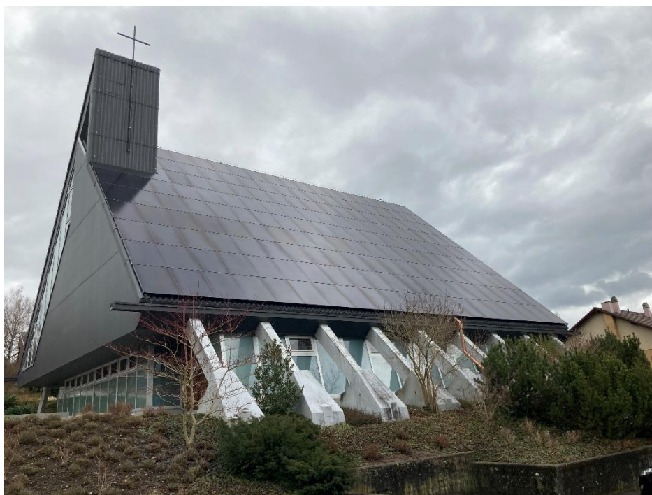
18. Februar 2022: Die Photovoltaik-Anlage auf dem Kirchendach geht ans Netz
