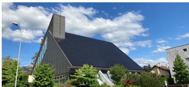
Sonnengeflutet: Die Photovoltaikanlage auf der Kirche
