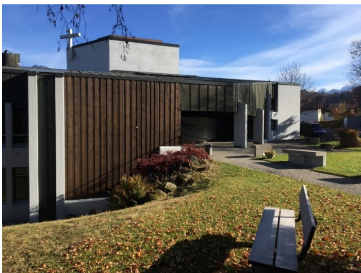
Durchgeführte Fassadenrenovation am Zentrum Bruder Klaus
