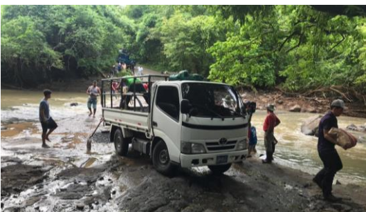
„Wenn keine Behörde kommt, dann machen wir es eben selber“: Las Mesas repariert die durch die Unwetter zerstörte Brücke.
