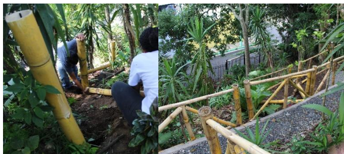
Terrassierung des Geländes und Anlegen von Wegen mit Bambusstruktur.
