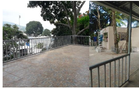
Terrasse und Küche/Chalet des Cafés im Rohbau.
