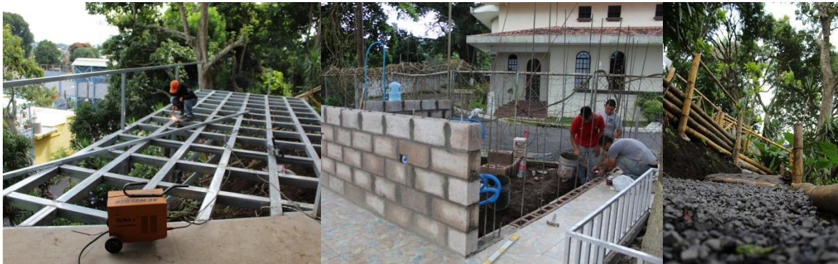
Bauphase von Terrasse, Chalet/Küche, sowie Wegen auf dem Areal des VIVERO-CAFÉ's.
